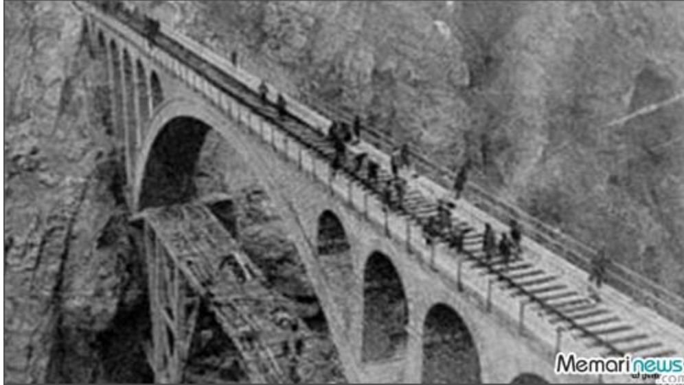
نمایی از عملیات ریل گذاری روی پل ورسک
