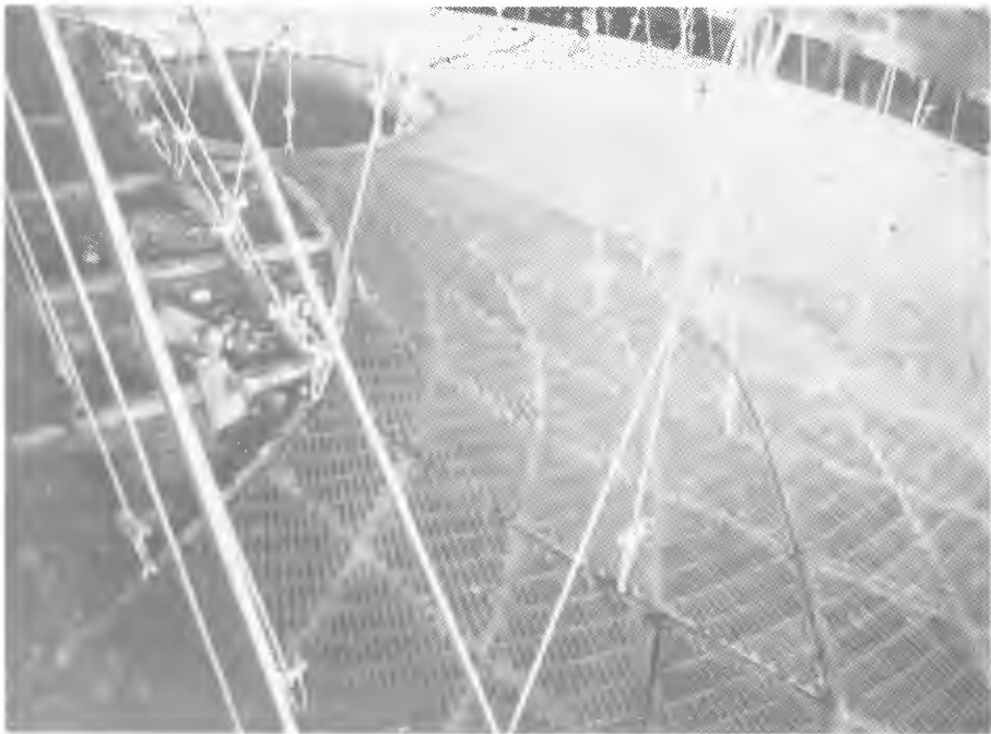
فاصله بین دو گنبد داخلی و خارجی که بوسیله ۴۲ مفتول فلزی معلق گردیده
