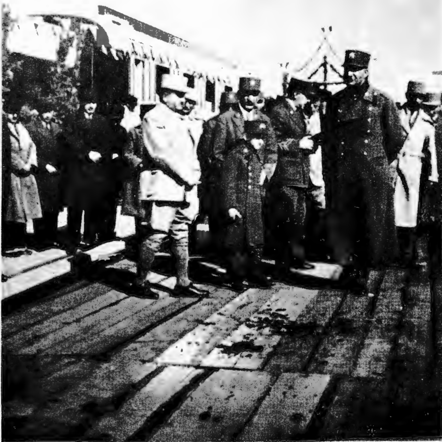
دریکی از بازدیدهای راه آهن ایستگاه بندر شاه
