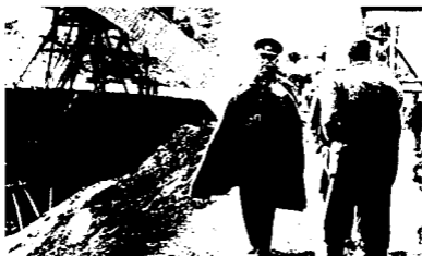
رضاشاه در بازدید از کارهای ساختمانی پل ورسک
