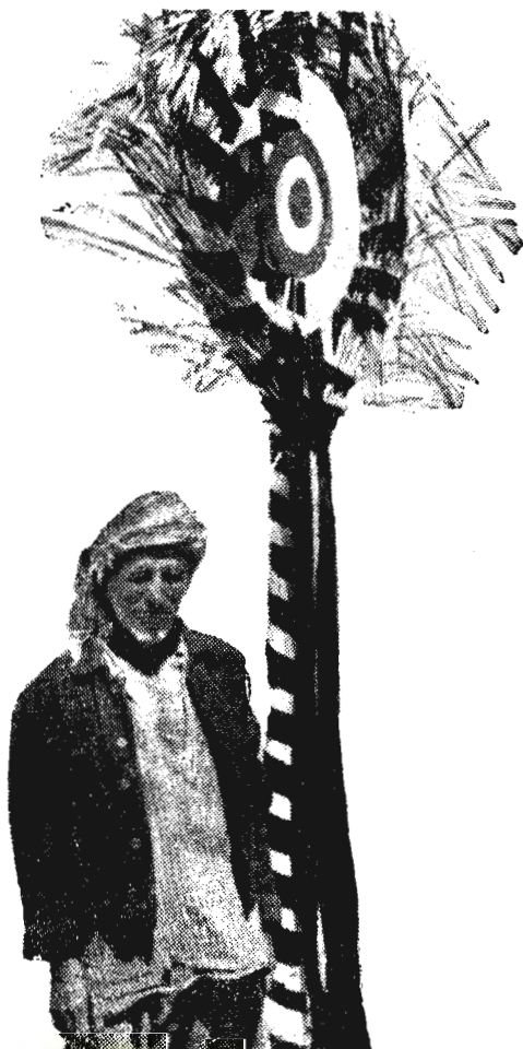
نمونه ای از دستک های چوبی که در طول نه کیلومتر فاصله بین فرودگاه تا ایستگاه راه آهن بفواصل ۵ متر نصب شده بود
